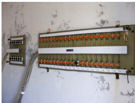
Fotografia 9 - Terminais de leitura dos piezómetros pneumáticos do corpo principal
