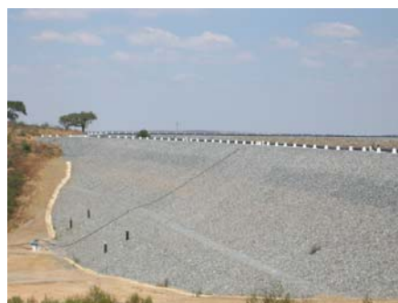
Fotografia 2 - Aspecto geral do paramento de jusante da portela ME1
