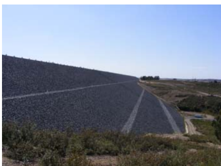
Fotografia 1 - Aspecto geral do paramento de jusante do corpo principal
